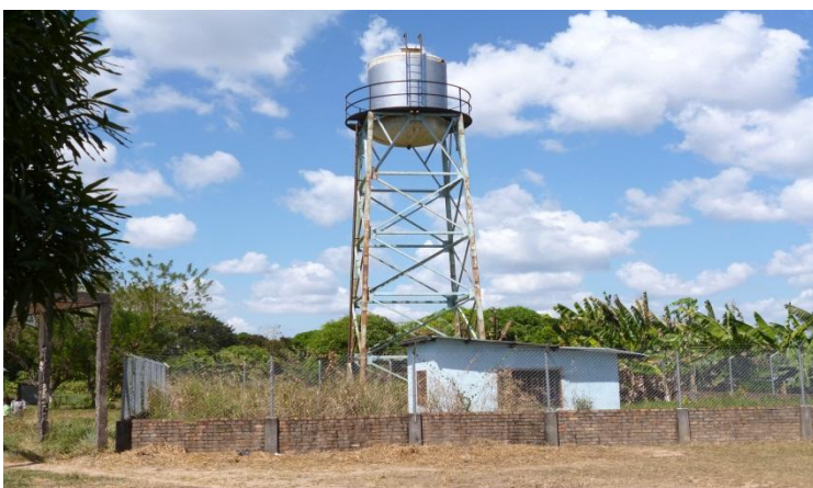
Instalaciones Acueducto-Comunidad Mochuelo
