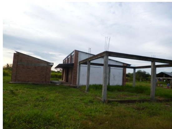
Construcción Aulas nuevas
