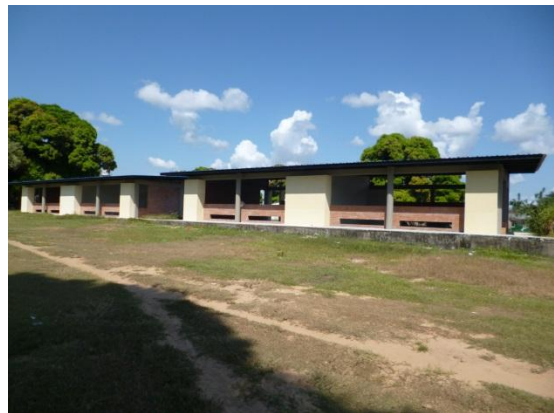
Construcción nuevas Aulas Escolares
